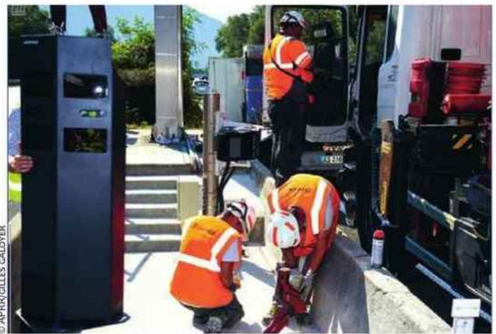
L'outil est en cours de test sur l'A 48
