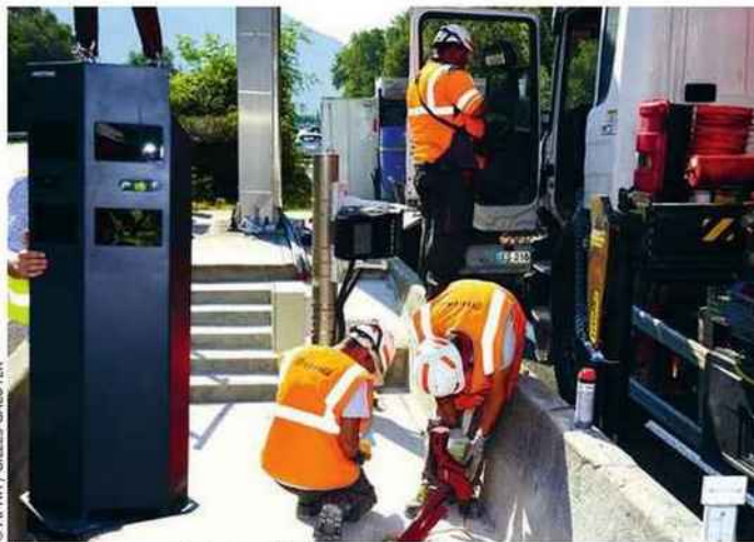
L'outil est en cours de test sur l'A 48
