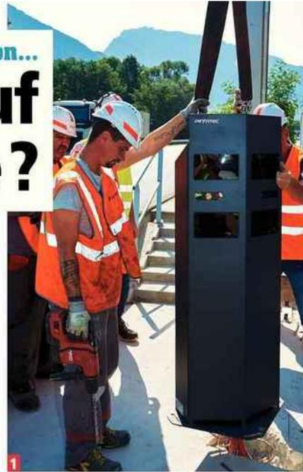
l'A1, l'A13, l'A16, l'A38 ou encore l'A620. Ses atouts: il est capable de distinguer le gabarit du véhicule, de détecter les excès de vitesse voie par voie et de prendre en flag les deux-roues motorisés. Comment le repérer? Facile, il est surmonté d'un module de télédétection par laser (Lidar).
